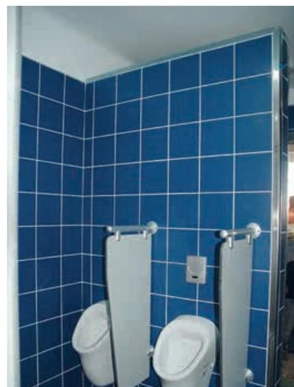
图4：在土耳其建造的一个预制厕所的内部
