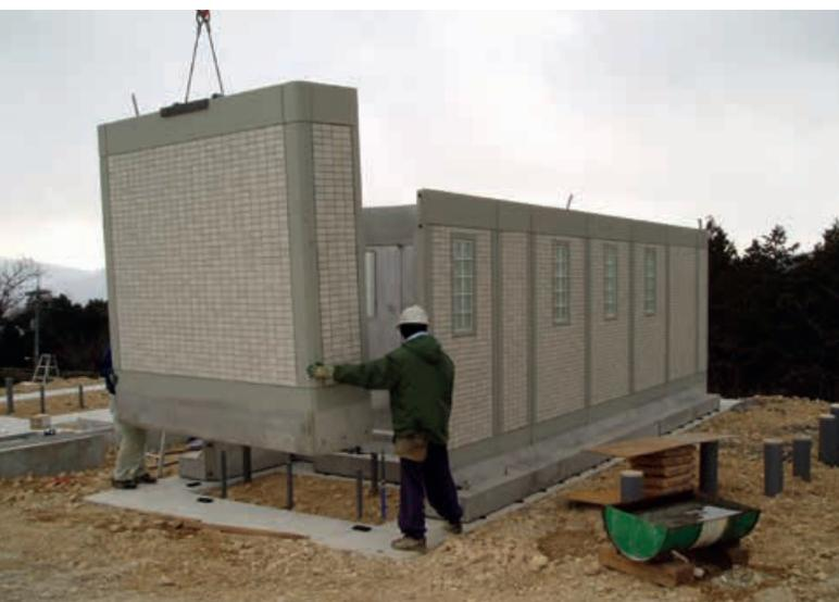
图2、3：在施工现场组装预制构件
